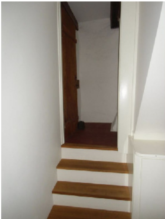
Steinerne Stufen u. Holztritte. Stiftsgasse 5/7, 4051 Basel
